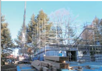
1階は、RC打ちはなし 2階は、杉の構造材 隣には、陶芸の釜小屋もある。
